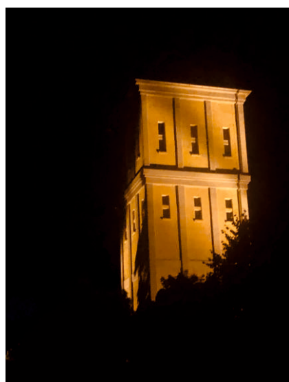
Wasserturm bei Nacht
