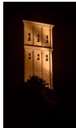
Wasserturm bei Nacht
